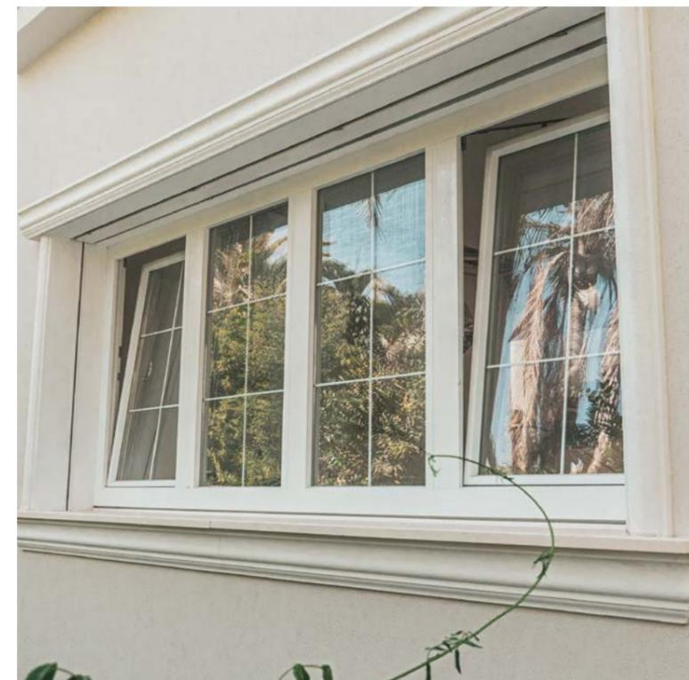
Wenn Sie an einem sonnigen Ort wohnen, ist es ratsam, für die größte Verglasung vorgespanntes Glas mit einem zusätzlichen HST-Test zu wählen, um das Risiko eines spontanen Glasbruchs bei ungleichmäßiger Erwärmung der Glasoberfläche auszuschließen.
